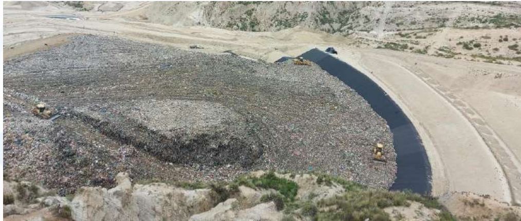
Compactación en el sector
