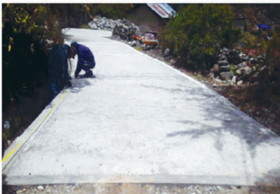
MEJ. VIAL TRAMO INGRESO A LA COMUNIDAD A CURVA U. EDUCATIVA DE PROG. 0+250 A PROG. 0+300 COMUNIDAD LLAULLINI
