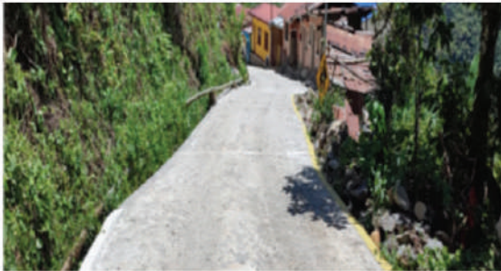
MEJ. VIAL TRAMO DESDE LA UNIDAD EDUCATIVA HACIA EL PUENTE YAHUILACA COMUNIDAD CAHUA GRANDE
