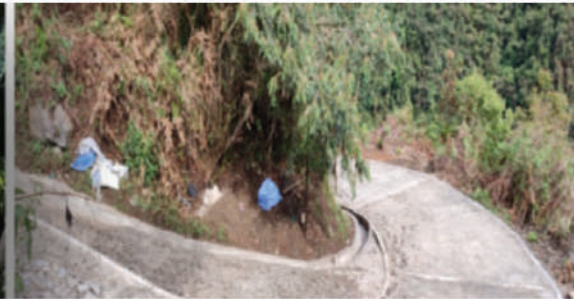
MEJ. VIAL DE PROGRESIVA 0+850 A PROGRESIVA 0+090 COMUNIDAD PUEBLO DE ZONGO
