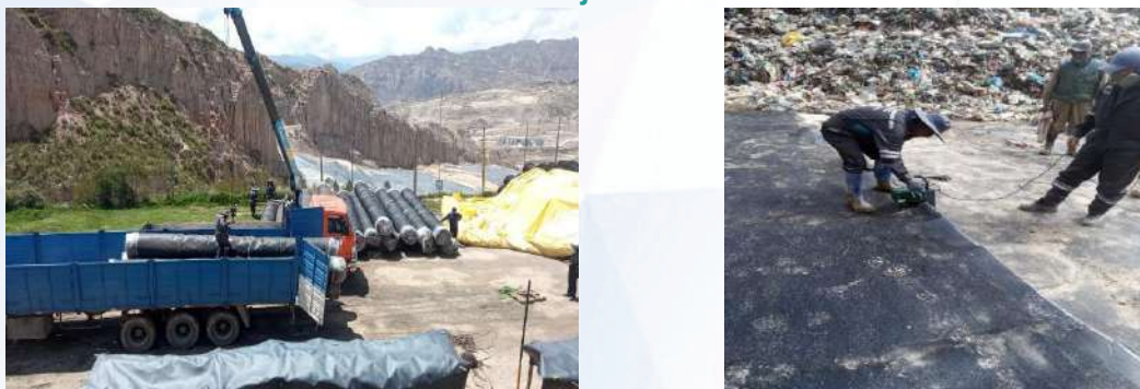
Materiales y trabajos de impermeabilización
