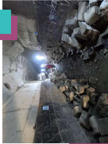
Fotografía: Reparación embovedado río Choqueyapu
