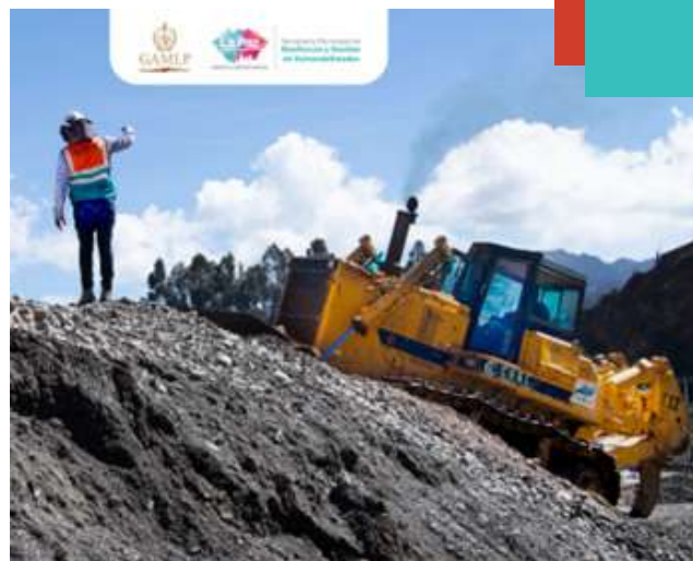
Fotografía. Personal de la SMRGV realizando trabajos.
