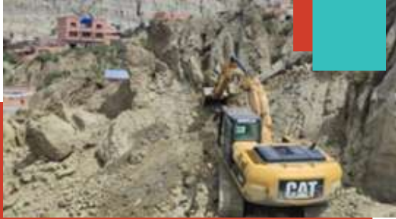
Fotografía. Sector Jinchupalla. Retiro de material del talud afectado
