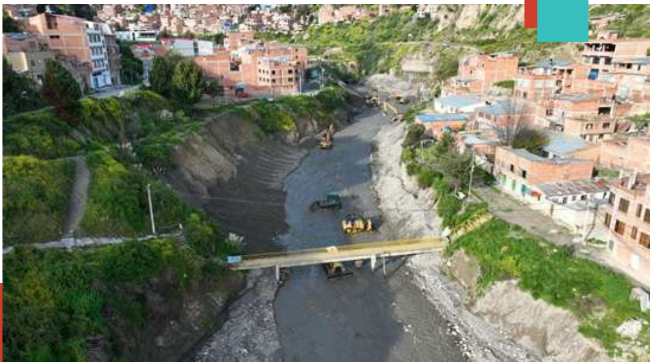
Fotografía. Río Orkojahuira (Zona Villa Lobos Municipal) – Intervención con maquinaria para la protección de taludes y obras especiales (pasarelas, viaductos) en ambos márgenes hidráulicos. Se realizó la reconformación de camellones y encauce del río.
